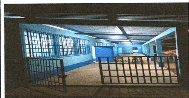
Foto 5: Así quedó el mantenimiento de la losa del Edificio Público
